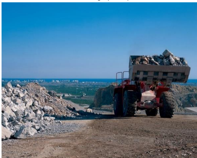
Ilustración 6: Planta de tratamiento de RCD del grupo empresarial BECSA SAU
